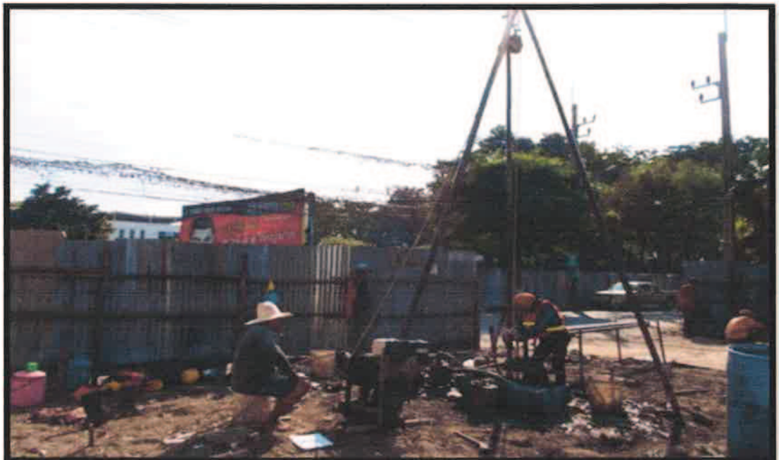
รูปภาพแสดงการเจาะสำรวจดิน โดยเครื่องเจาะแบบ MOTORIZE SYSTEM
