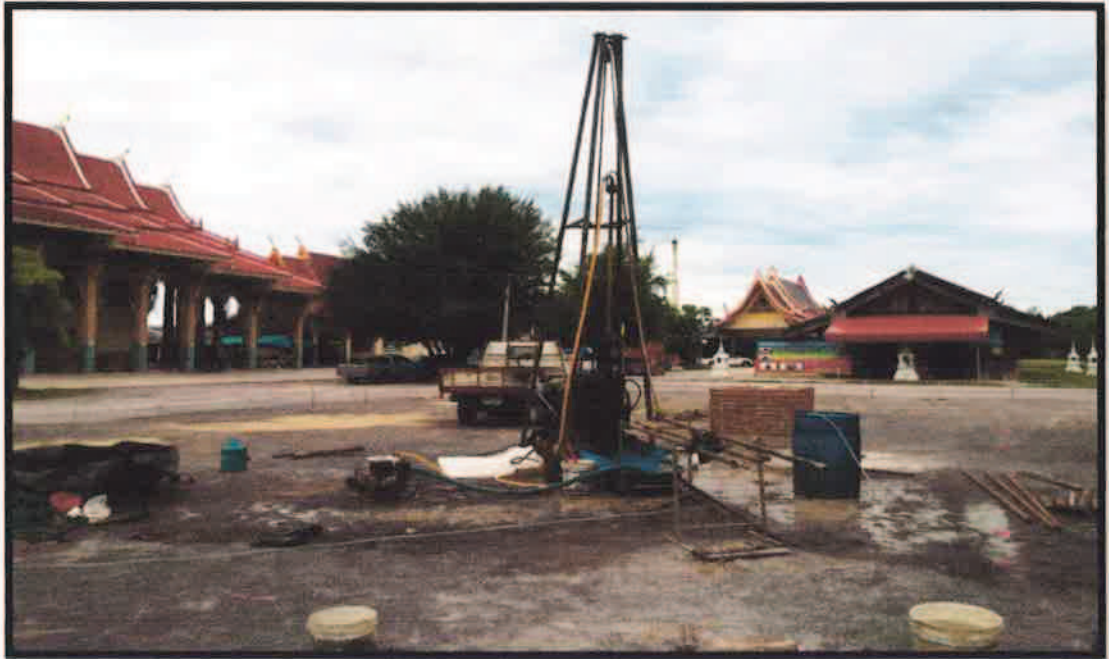
รูปภาพแสดงการเจาะสำรวจดิน โดยเครื่องเจาะแบบ ROTARY SYSTEM
